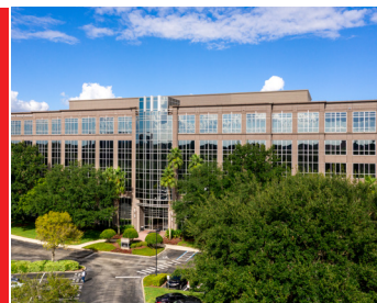
Primera Tower V 255 Primera Blvd Lake Mary, FL
